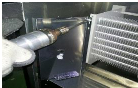
D. Remove the air guide (L/R)
